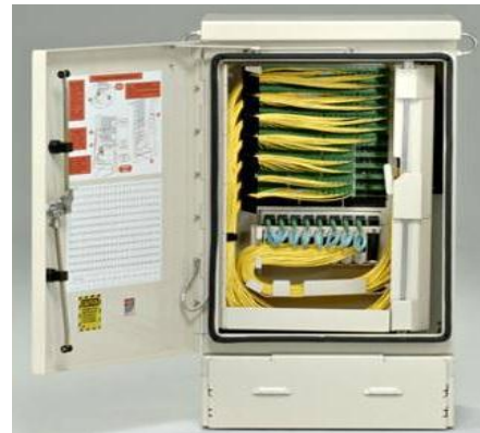
Abbildung 96: Vorbestückter und terminierter Verteiler
