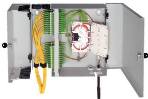
Abbildung 38: Beispiel eines IP20 wandmontierten BEP
