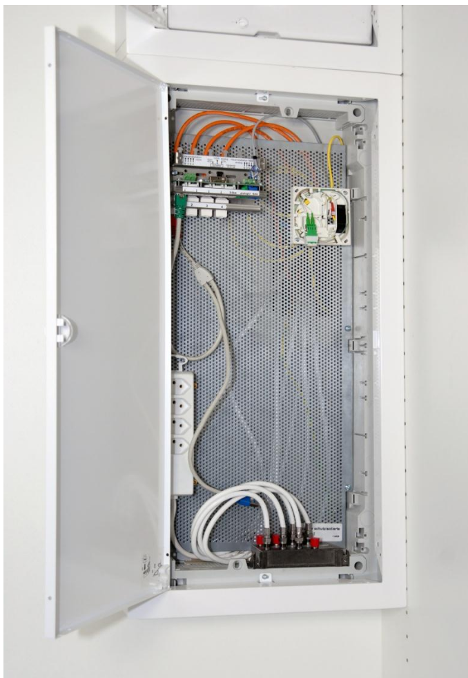
Abbildung 45: In einen Verteilerschrank integrierte OTO
