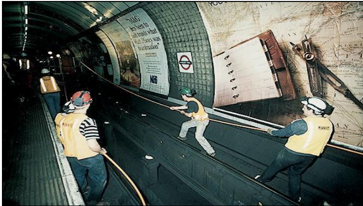
Abbildung 85: Kabelinstallation in einem Eisenbahntunnel
