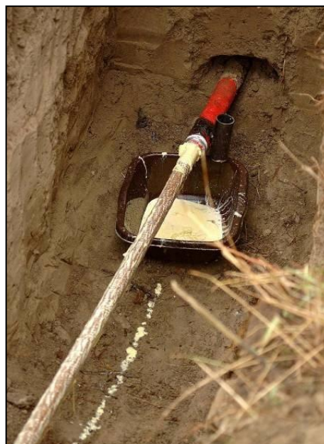
Abbildung 56: Kabelentkernung
