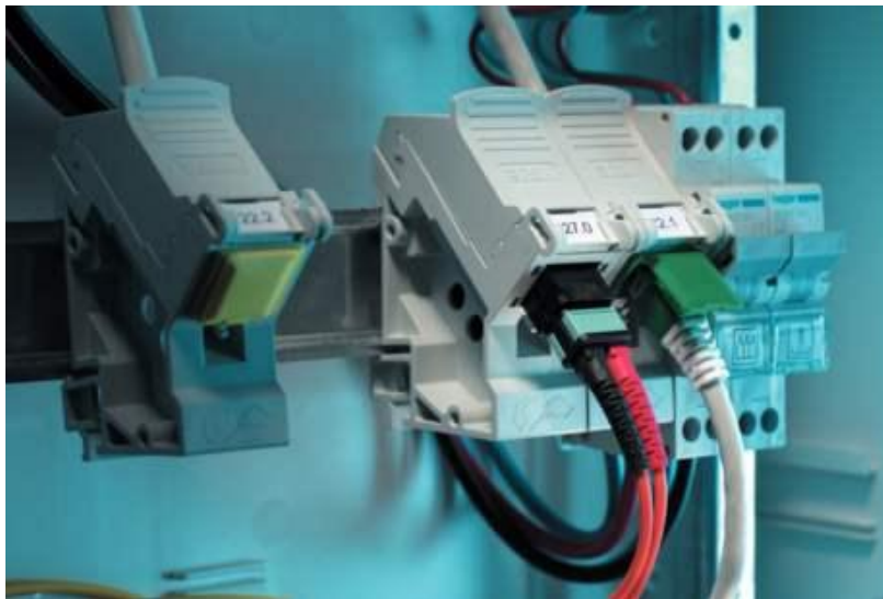
Abbildung 46: In die elektrische Hausverteilung integrierte OTO
