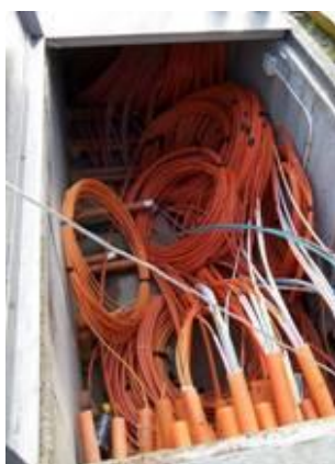
Abbildung 89: Rohre in POP-Nähe
