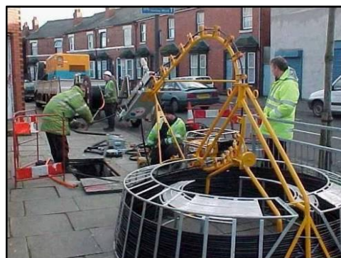
Abbildung 48: Ausbau der Rohrinfrastruktur
