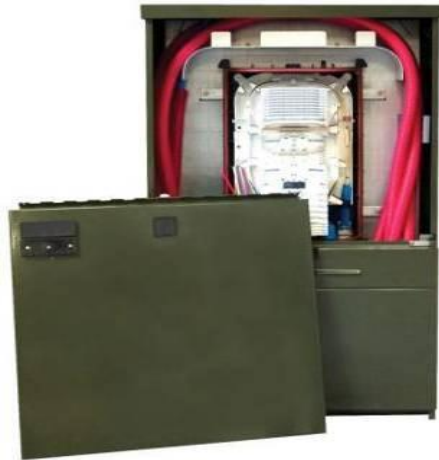
Abbildung 95: Typischer Straßenverteiler.
