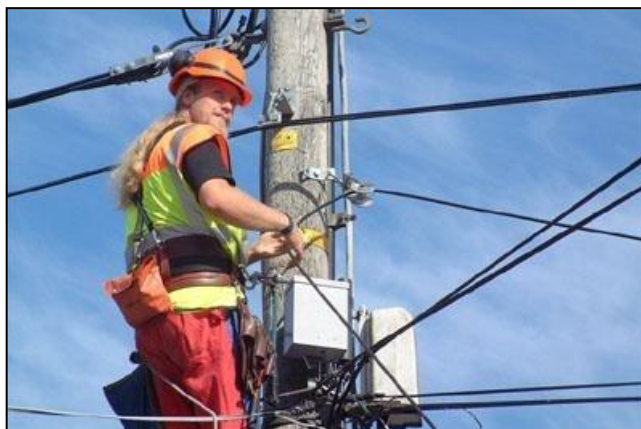
Abbildung 77: Luftkabelinstallation.
