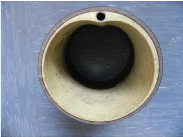
Abbildung 19 Einbau Kurzliner zusammen mit Schutzrohr für Kabel, Quelle: Gerald Preuß, Baubetriebshof der Stadt Oer-Erkenschwick
