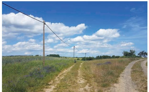
Abbildung 23: Oberirdische Telekommunikationslinie, Quelle: Breitbandzentrum Niedersachsen-Bremen
