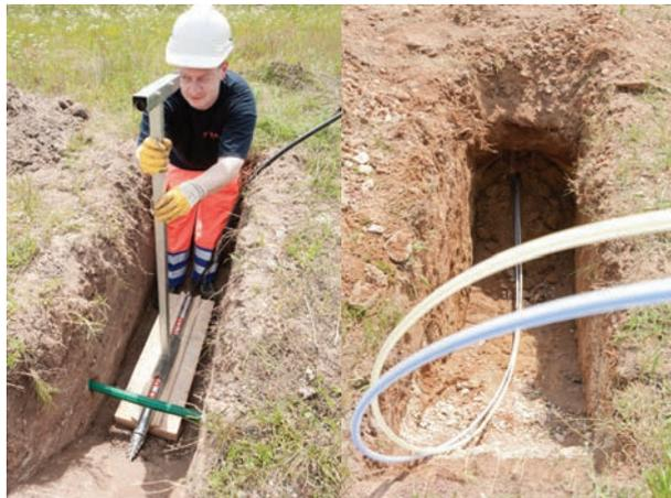
Abbildungen 12 und 13: Erdraketentechnik zur Herstellung eines Hausanschlusses, Quelle: REHAU AG+Co
