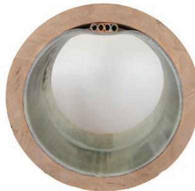
Abbildung 18: Einbau Schlauchliner zur Kanalsanierung und Schutzrohrpaket für Kabel,
