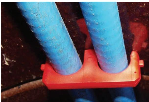
Abbildung 17: Kabelbefestigung mittels Doppelanker,
