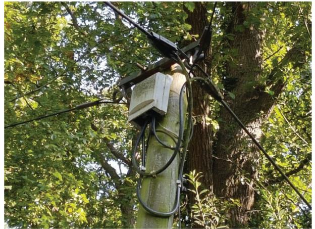
Abbildung 22: Mast mit Querträger und Verzweiger für Kupferkabel, Quelle: Deutsche Telekom Technik GmbH
