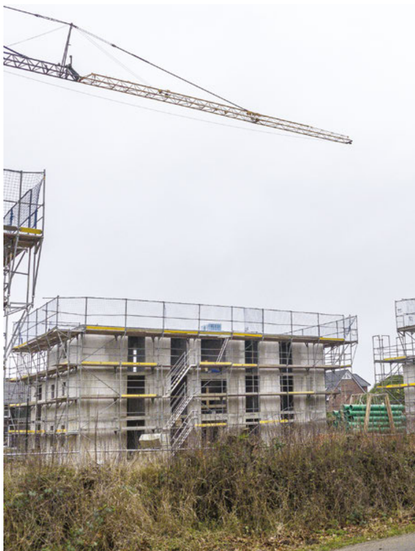
Abbildung 1: Beispiel des Neubaus eines Mehrfamiliengebäudes Quelle: ANGA Der Breitbandverband e. V.
