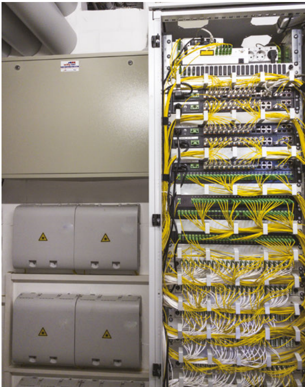
Abbildung 48: Einzelfaser-Management zur Anbindung der WE (FTTH) Quelle: willy.tel GmbH
