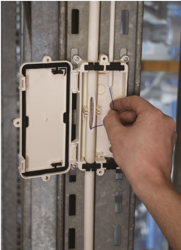
Abbildung 57: Ausleitung von Glasfaserkabeln aus einer Steigleitung heraus Quelle: Emtelle GmbH
