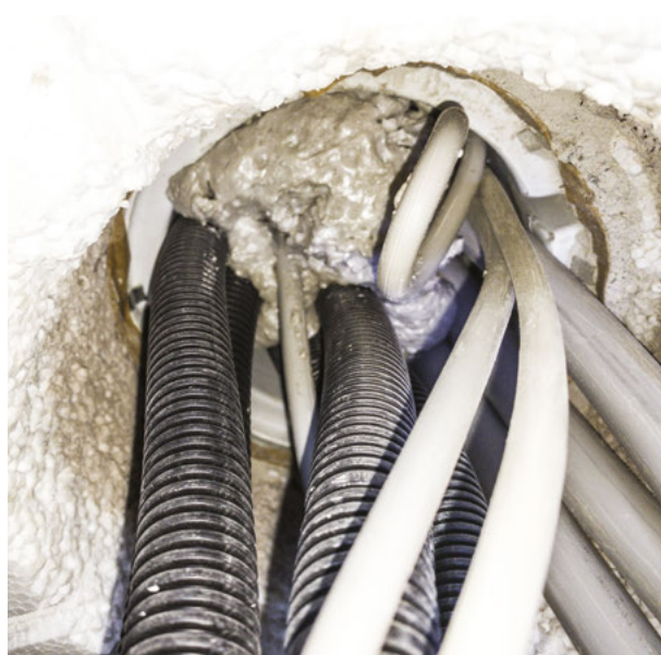
Abbildung 60: Brandschottung von Elektroinstallationsrohren und Kabeln in einem Steigschacht Quelle: ANGA Der Breitbandverband e. V.
