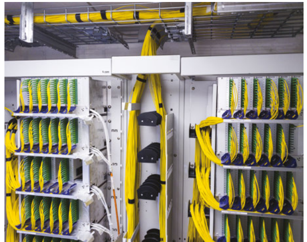
Abbildung 48: Einzelfaser-Management zur Anbindung der WE (FTTH) Quelle: willy.tel GmbH
