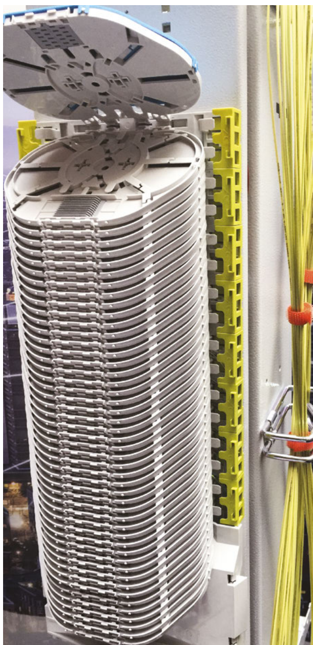
Abbildung 35: Einzelfaser-Management am GF-AP für eine PtP-Verbindung Quelle: ANGA Der Breitbandverband e. V.
