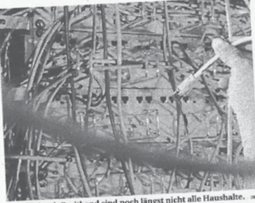
Verkabelt mit Breitband sind noch längst nicht alle Haushalte.
