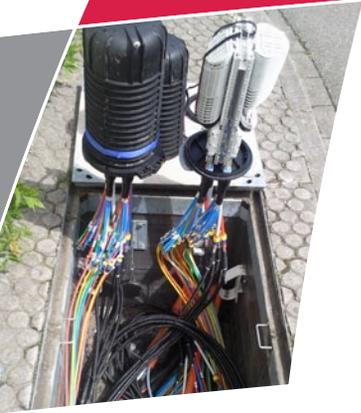
Schacht mit Muffen und Spleißkassetten
