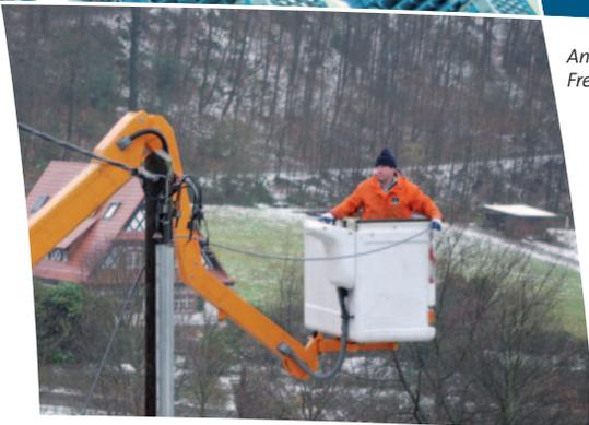
Anbringen eines LWL Kabels am Freileitungsmast
