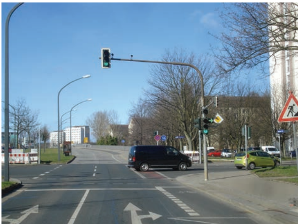
Abbildung 16: Lichtsignalanlage Quelle: Landeshauptstadt Dresden, Straßen- und Tiefbauamt
