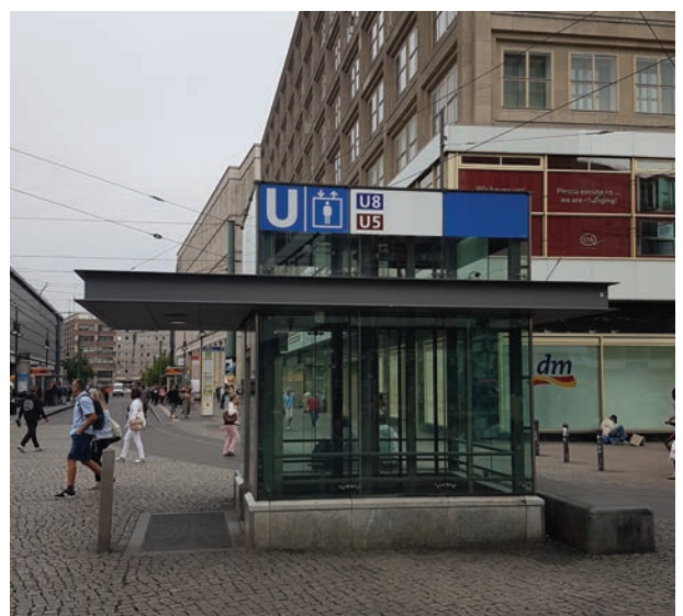
Abbildung 20: Dachkonstruktion als Trägerstruktur Quelle: BMVI
