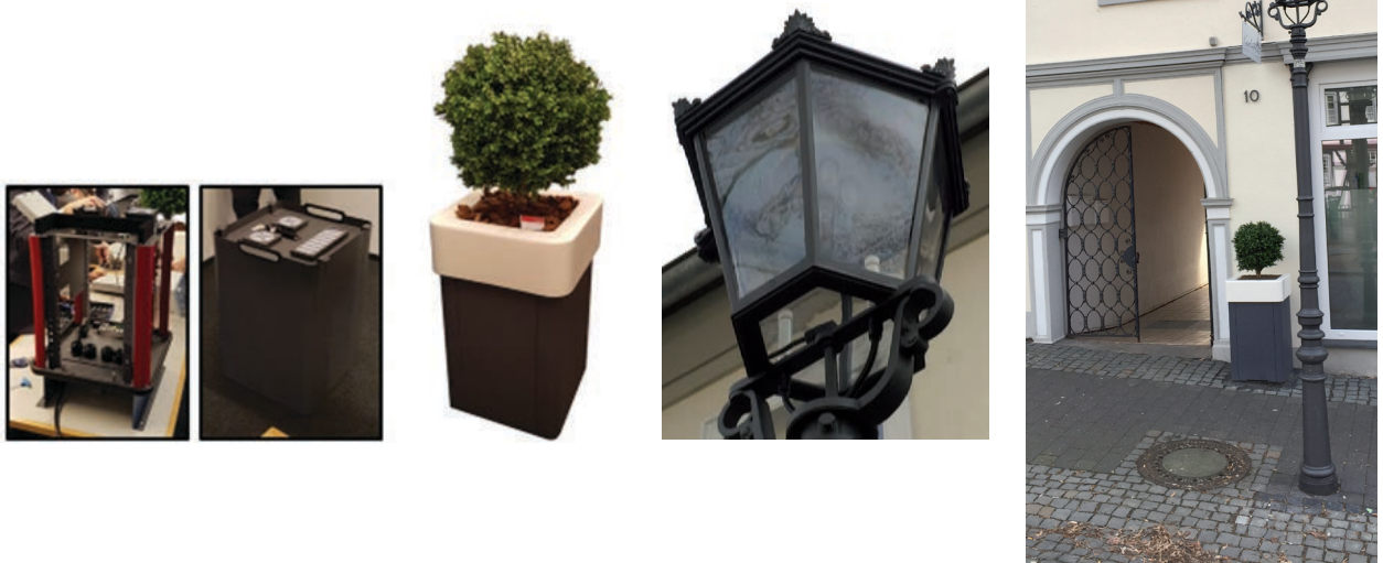
Abbildung 7: Small Cell-Installation an einem Beleuchtungsmast mit camouliertem Nebensteller Quelle: Telekom, Raycap
